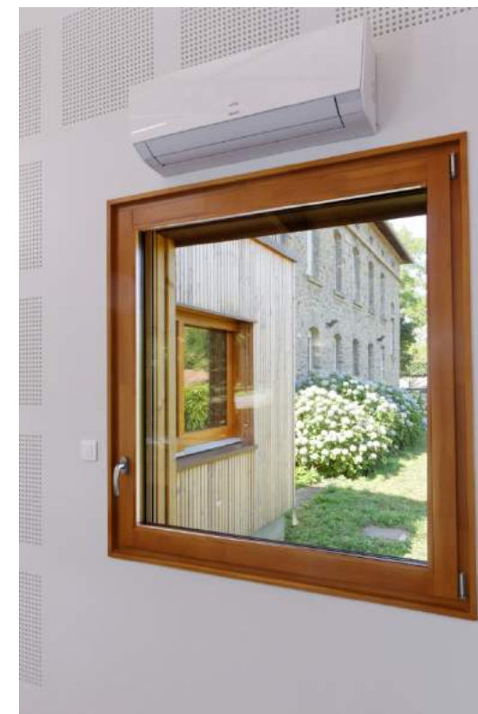
Fenêtre 1 vantail ouvrant à la Française oscillo battant
