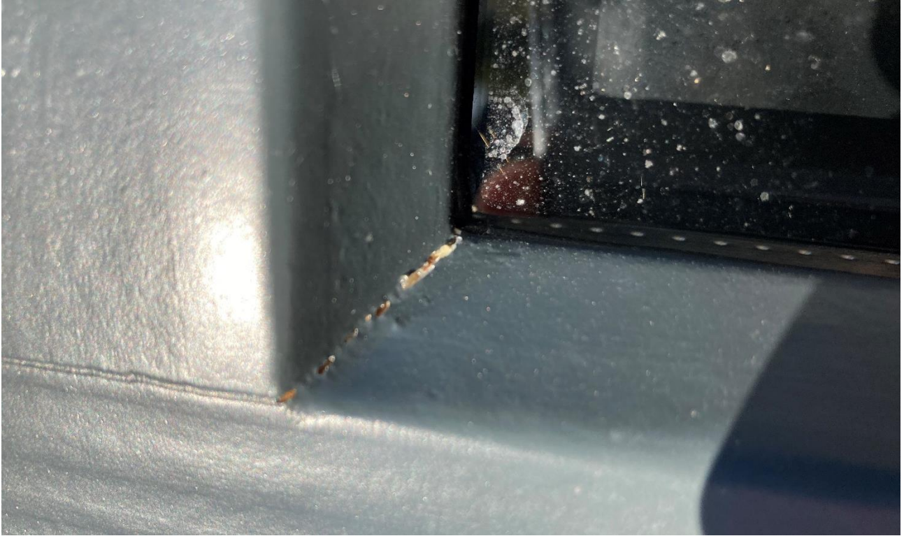
Photographie 4 : Craquelage de l'angle d'assemblage en partie basse du vitrage
