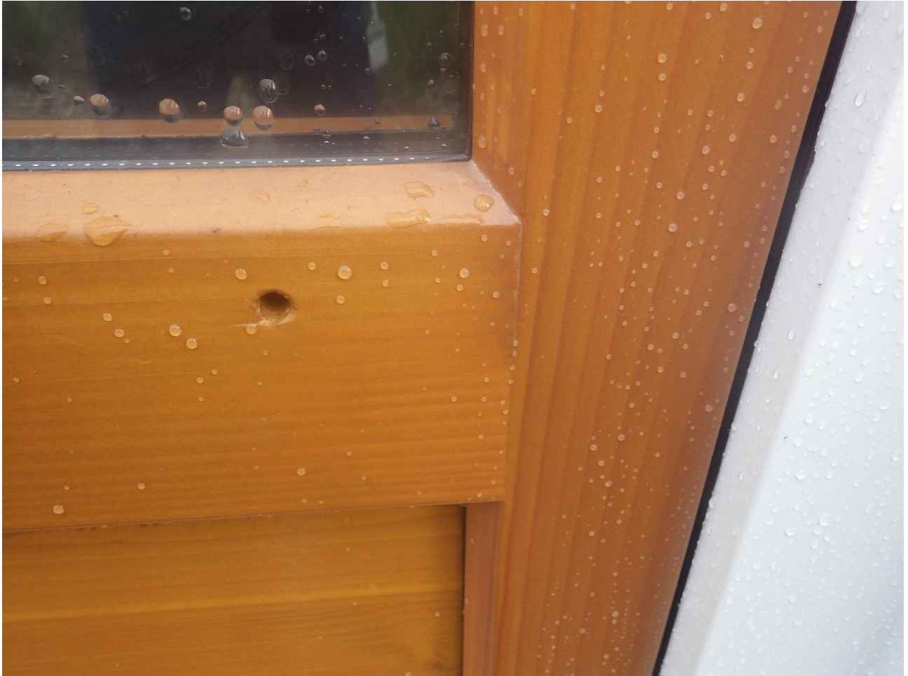
Photographie 7 : Craquelage de l'angle d'assemblage en partie basse du vitrage
