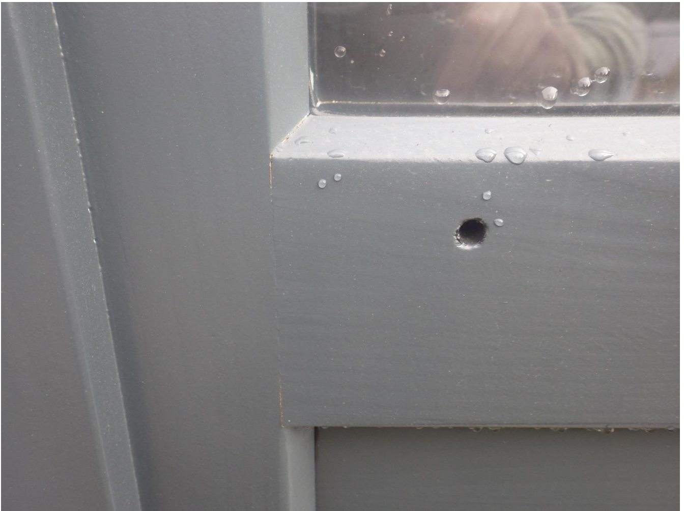
Photographie 3 : Craquelage de la traverse liaison panneau de soubassement/vitrage
