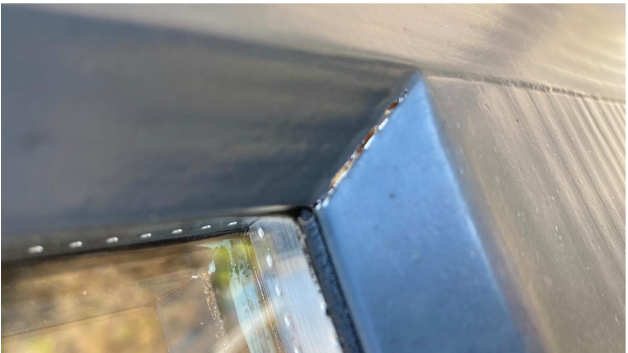
Photographie 5 : Craquelage de l'angle d'assemblage en partie haute du vitrage
