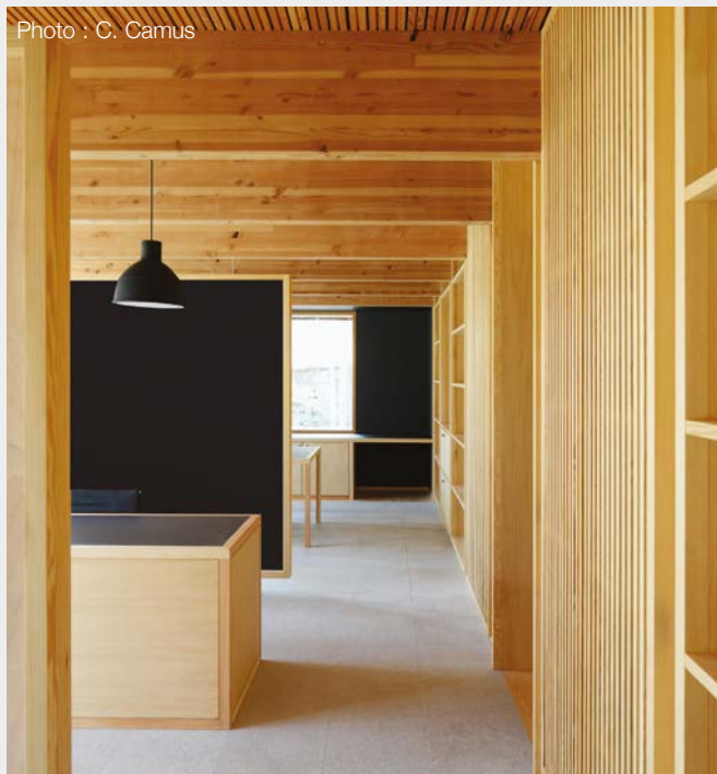
Le Rouget : L'immeuble regroupe un atelier d'architecture et deux logements. La structure est réalisée en poteaux-poutres douglas lamellé-collé et en mur à ossature bois.
