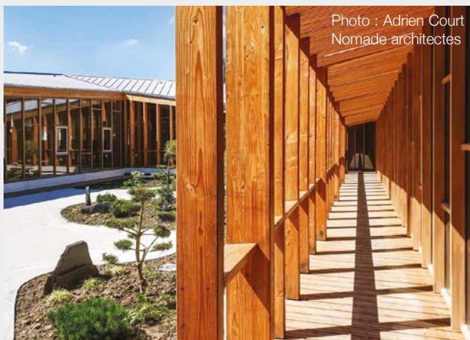
Dojo Kuki, à Epinay-sur-Seine : le douglas a été choisi pour sa teinte chaleureuse et sa déclinaison possible sur l'ensemble des éléments architecturaux : charpente en BLC, bardages à claire-voie, capots des murs rideaux, épines bois intérieures, plinthes, encadrement des portes intérieures...
