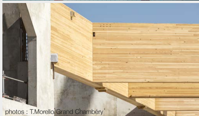
Piscine de Chambéry : L'entreprise Cosylva a fabriqué les 285 m 3 de charpente en lamellé-collé Douglas, dont 50% en GL28. Les plus longues poutres dépassent les 30 m portées.
