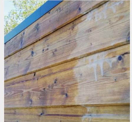
Stabilisation au Netrol 200 après déshuilage
