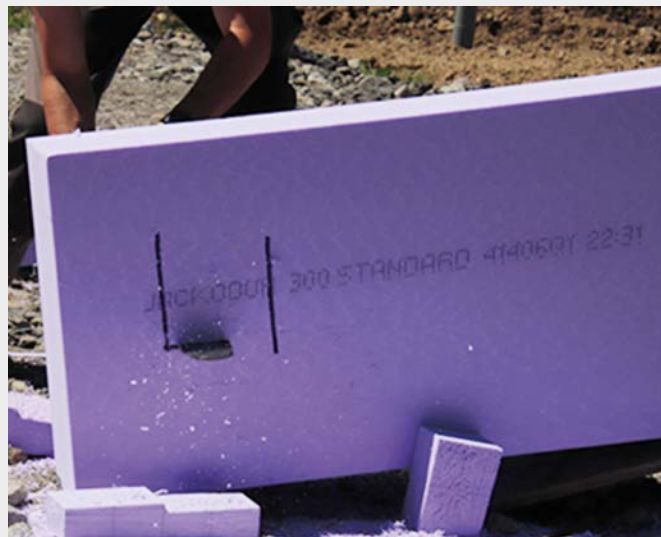
Les éléments nécessitant le passage des réservations sont découpés très facilement à la scie ou au cutter. Avec une scie à fil chaud il est également possible de recréer facilement, si besoin, des feuillures alternées avec un tracé d'une très grande précision et sans aucune salissure.
