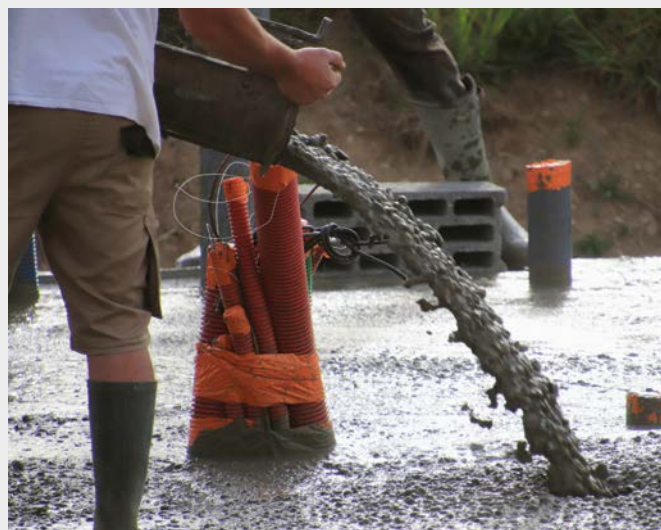
La dalle béton ferrillée de 250 mm d'épaisseur est enfin coulée sur la toute la surface.
